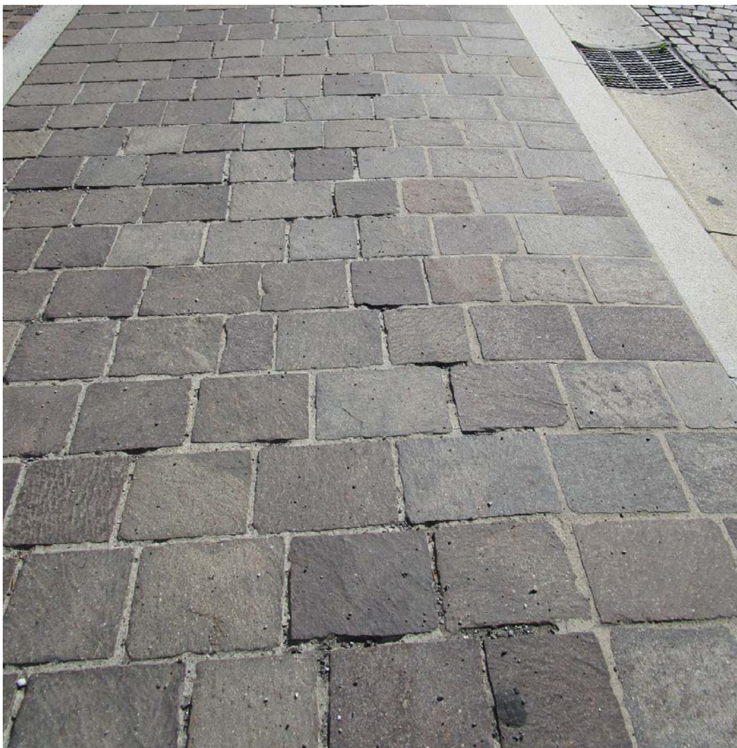
Foto 11: Porfido su marciapiede tipo da rifugare.
