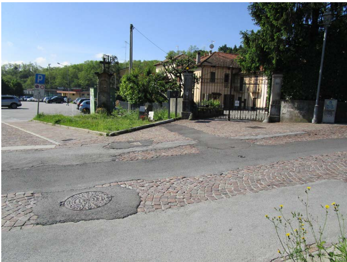
Foto 5: Attraversamento tipo in asfalto in proprietà privata.
