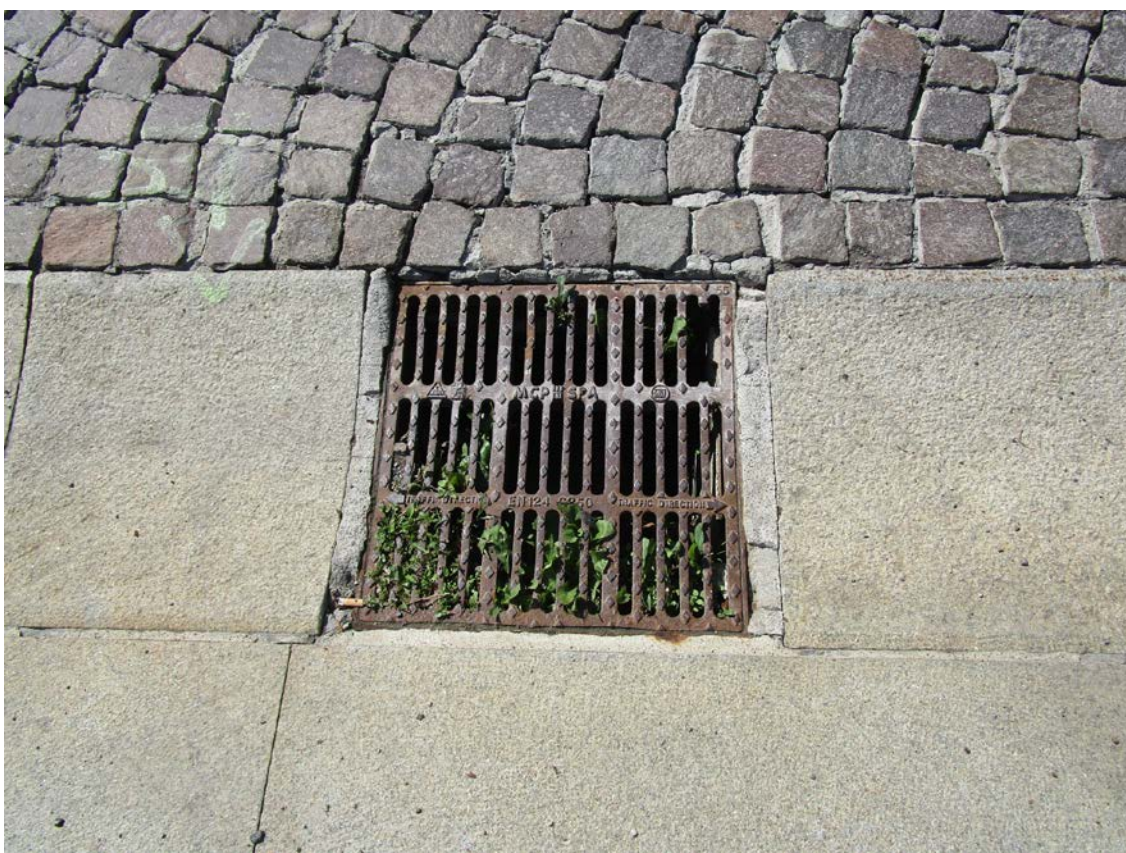
Foto 8: Griglia caditoia tipo da sostituire.
