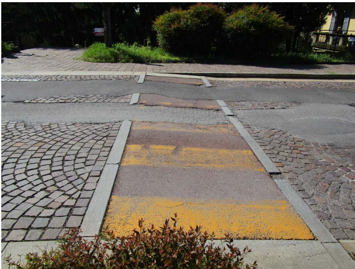
Foto 9: Stato di dissesto attraversamento pedonale rialzato tipo.
