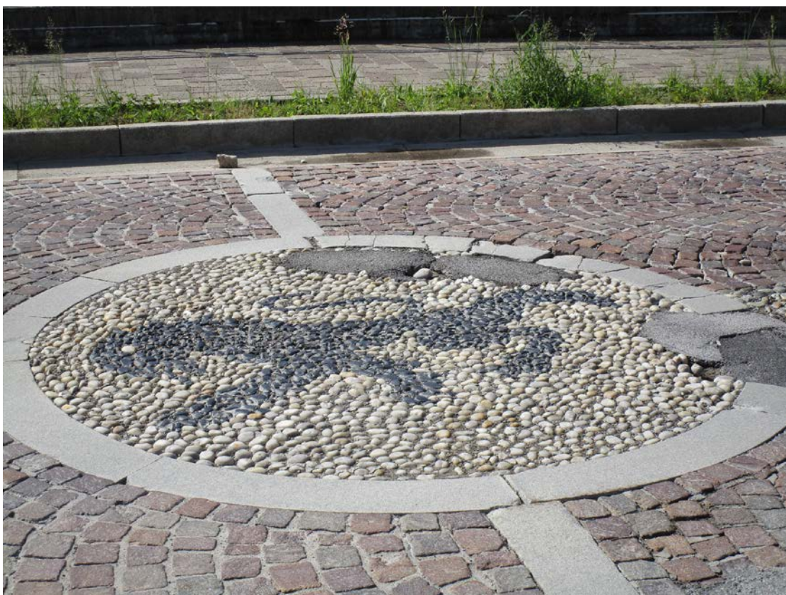
Foto 6: Stato di dissesto rosone tipo.
