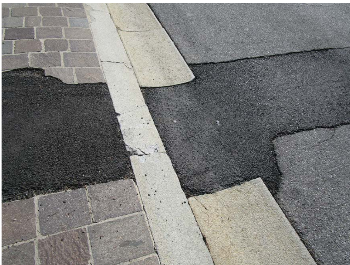
Foto 10: Stato di dissesto canaletto e lastra in granito tipo.
